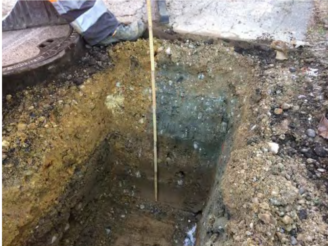
Abb. 67 (Schürf „Stelle 2“; Quelle: Tiefbauamt, 16.11.2018)
