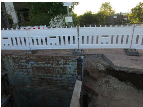
Bereich Haus Nr. 32 / 19 Richtung Haus 30 (ehemalige Bushaltestelle), 2019
