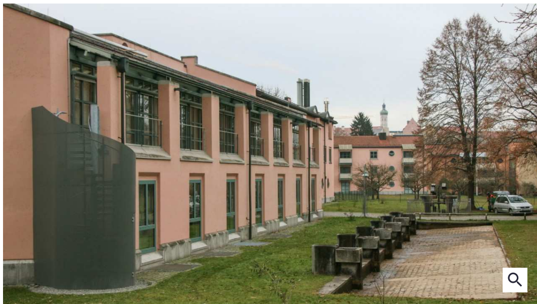
Vom Hauptgebäude der Sparkasse Dachau am Sparkassenplatz blickt man auf das Rathaus (ganz hinten) - der Konflikt um die Bestellung des Stadtrats Peter Gampenrieder für den Zweckverband des Kreditinstituts kommt auch einer Zurückweisung des ganzen Stadtrats gleich. (Foto: Niels P. Jørgensen)
